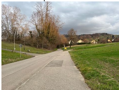
Abb. 67: Ortseingang Richtung Hofweier
