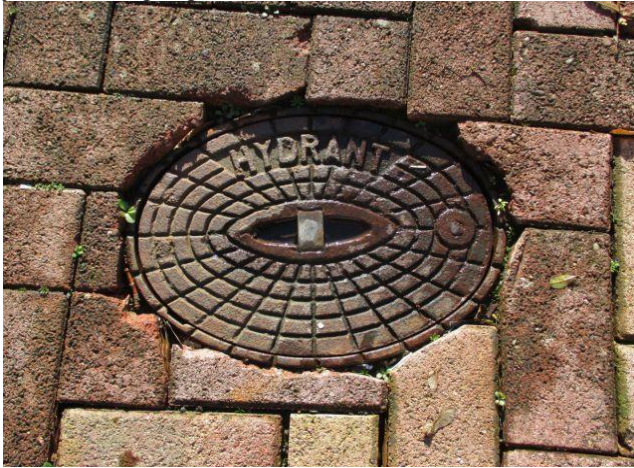
Abb. 06: Unterflurhydrant
