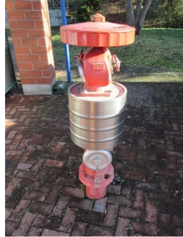
Abb. 07: Überflurhydrant
