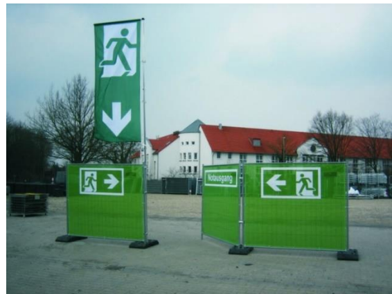
Abb. 04: Beispiel für eine Rettungswegfahne und Bauzahnfahnen (Quelle: www.hmr-gmbh.com )
