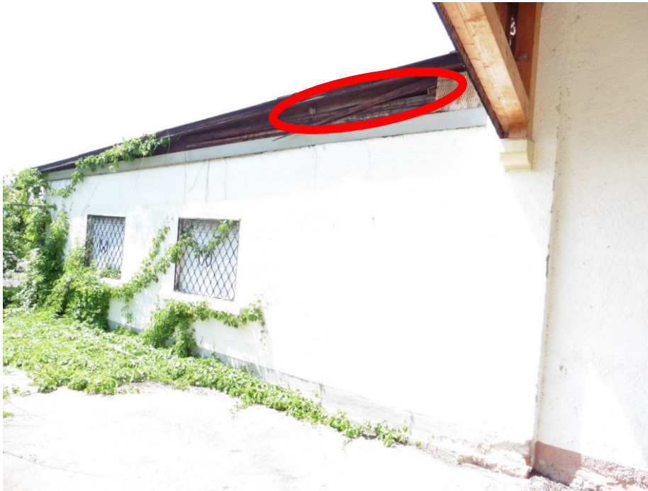
Abb. 2: Flurstück 2685 - potenzielles Tagesquartier für Fledermäuse / potenzieller Revierstandort des Haussperlings im mittleren Gebäudebereich (rot umrandet)
