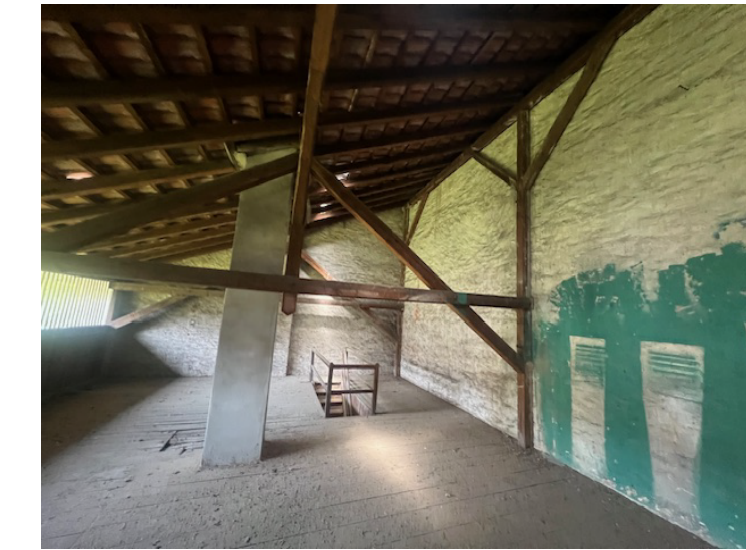
Foto Innen Dachstuhl + Fassade West Bestandsgebäude
