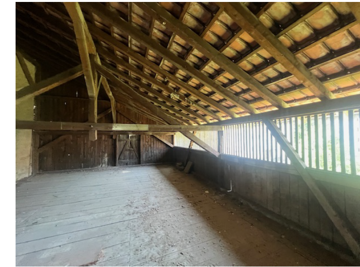
Foto Innen Dachstuhl + Fassade West Bestandsgebäude
