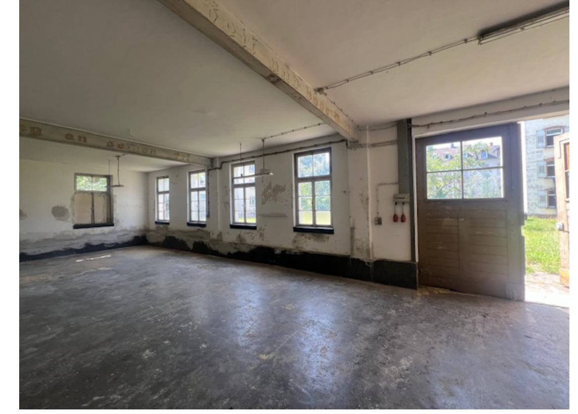
Foto Innen - Teilsicht West/Süd Bestandsgebäude
