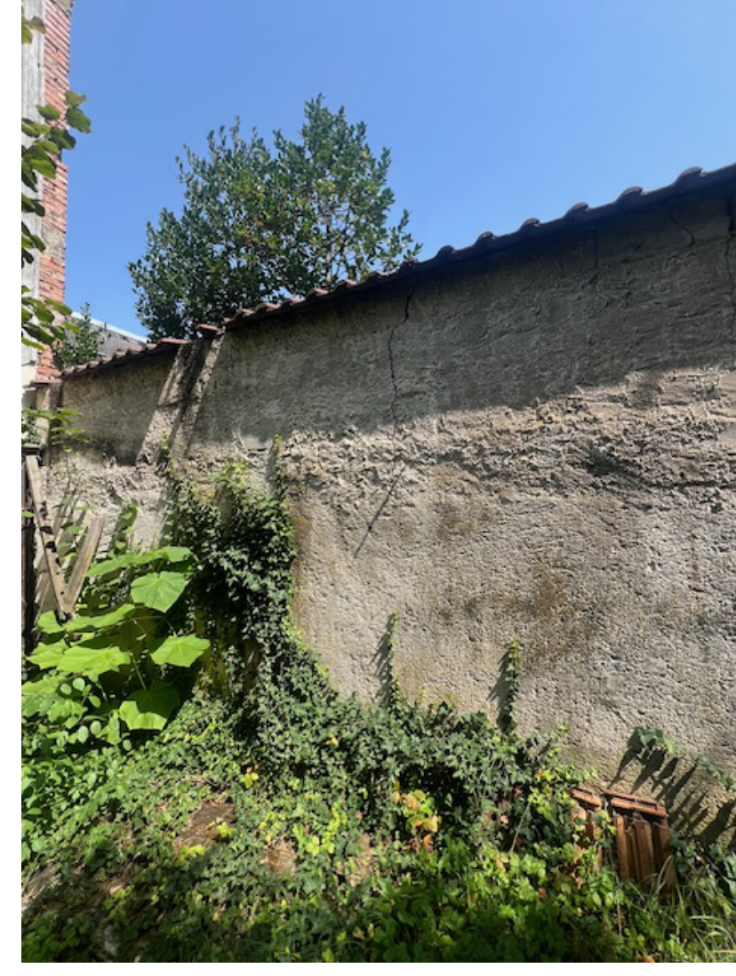
Foto Grenzwall Süd zu Nachbar
