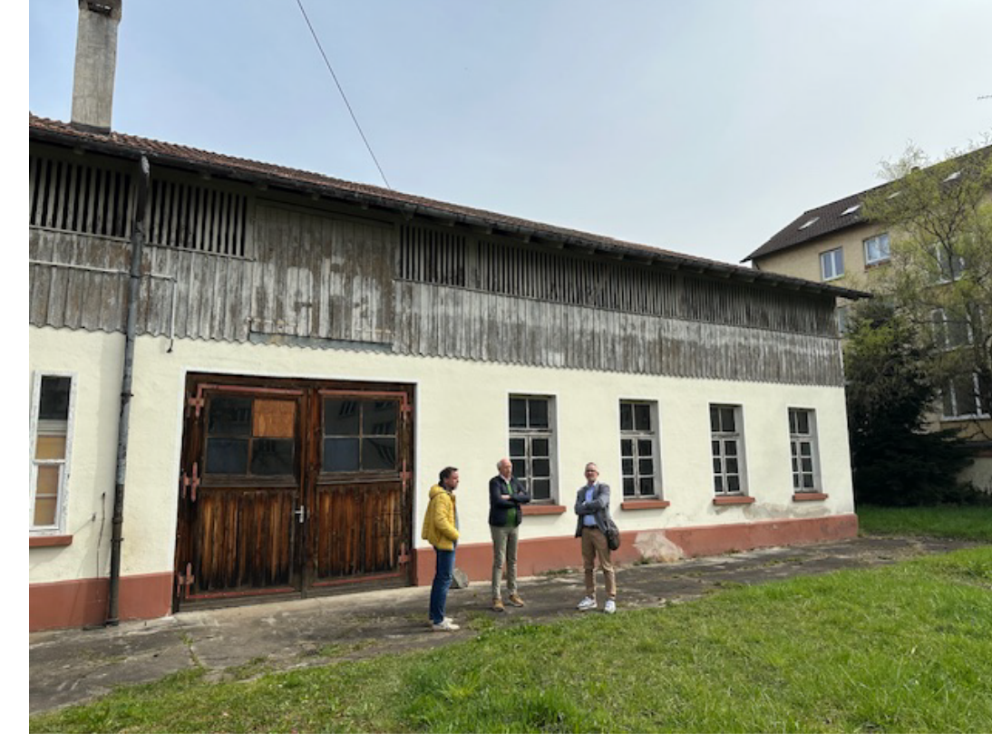
Foto Teilsicht West Bestandsgebäude
