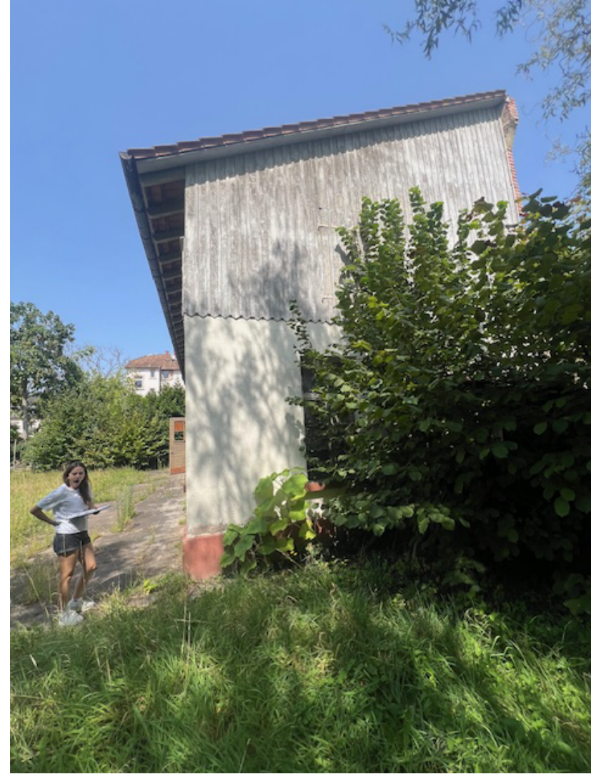
Foto Ansicht Süd Bestandsgebäude
