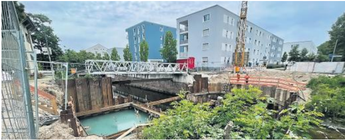
Der Neubau der Mühlbachbrücke verzögert sich: Seite 3
