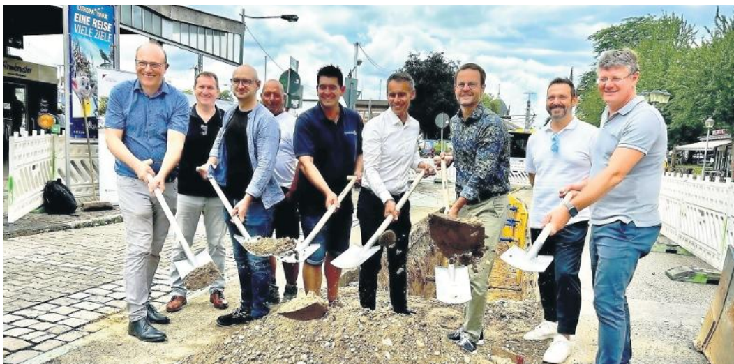
Der Fernwärmeausbau markiert den Beginn der Sanierungsarbeiten im Bahnquartier.
