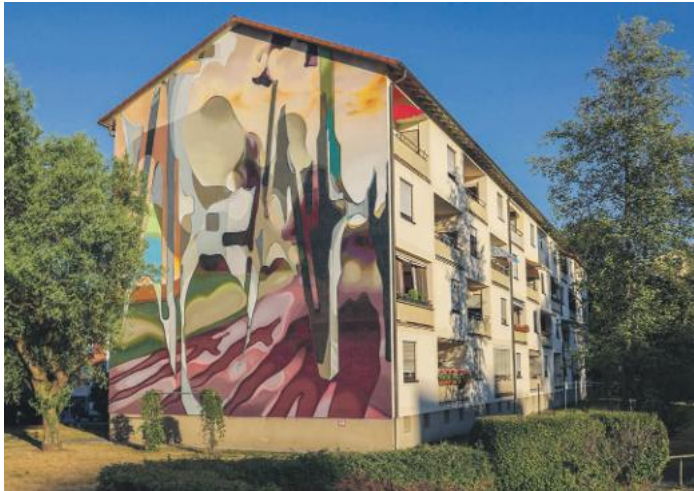
Aus einer Fassade wird ein Kunstwerk.
