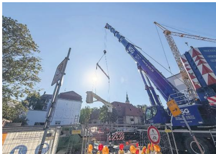
Eins von sechs Brückenteilen für die Mühlbachbrücke.
