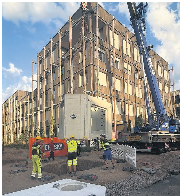
Per Schwerlastkran wird der Schacht eingehoben.
