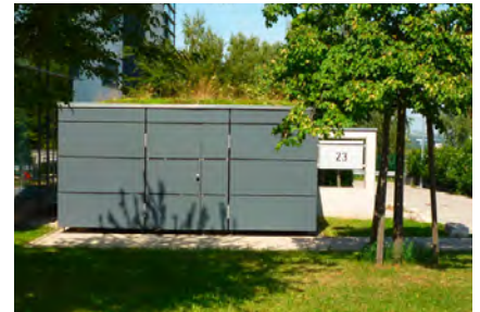
ABB. 067 ✓ Nebenanlage im Innenhof, mit grauen Eternitplatten verkleidet und begrüntem Dach
