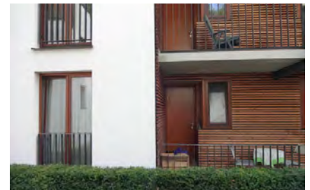
ABB. 063 ✓ Gelungene Kombination: heller Fassadenputz, Fensterrahmen mit dunklem Holz
