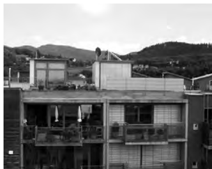
ABB. 051 ✗ NEGATIVBEISPIEL Ein Wirrwarr an unterschiedlichsten Dachaufbauten erzeugt unruhige Dachlandschaften und versperrt dem Nachbarn die Aussicht.
