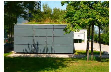
ABB. 071 ✓ Nebenanlage im Innenhof, mit grauen Eternitplatten verkleidet und begrüntem Dach
