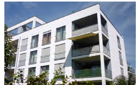
ABB. 060 ✓ Helle, weiße Putzfassade, Balkone sind in die Fassade als Loggien integriert, Scharnhäuser Park, Ostfildern.
