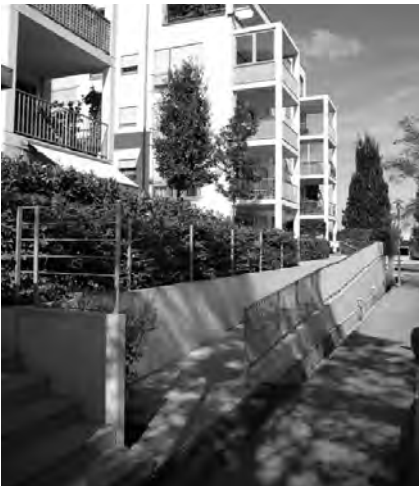
ABB. 035 ❌ NEGATIVBEISPIEL Der Eingangsbereich liegt ca. 1,0m über dem natürlichen Gelände. Der Hauszugang ist nur über Treppen erreichbar. Eine Barrierefreiheit ist zwar gewährleistet, aber nur über eine sehr lange Rampe. Das Erscheinungsbild der Vorzone wirkt wenig einladend und verbaut.
