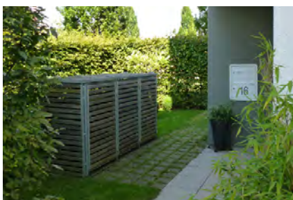
ABB. 164 ✓ Begrünter Vorzonenbereich mit „versteckter“ Nebenanlage, Holzlatzunge wirkt angenehm zum Grünbereich.
