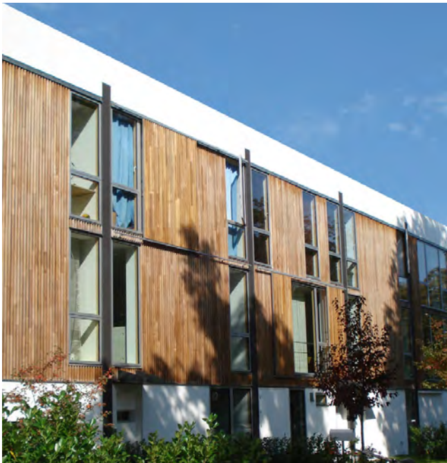
ABB. 107 ✓ 3-geschossiges Gebäude: gelungene Holz-/Putzfassade
