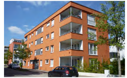
ABB. 061 ✓ In warmen Farbtönen gehaltene Putzfassade, Balkone sind in die Fassade als Loggien integriert, Scharnhäuser Park, Ostfildern.
