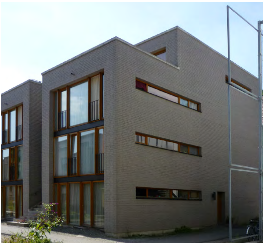
ABB. 085 3-geschossiges Gebäude mit zusätzlichem Dachgeschoss
