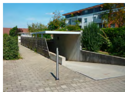
ABB. 092 Tiefgaragenzufahrt wirkt trotz der Überdachung nicht dominant, Mauern sind auf ein Minimum reduziert bzw. die Randeinfassung ist mit einer Holzlattung und zusätzlicher Begrünung hergestellt.
