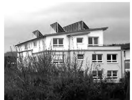
ABB. 052 ✗ NEGATIVBEISPIEL Zu hohe Dachaufbauten stören die Dachlandschaft.
