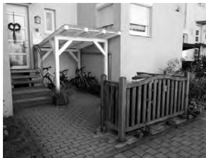
ABB. 118 ✗ NEGATIVBEISPIEL Durch Mülltonnen sowie Fahrradabstellanlagen verbaute Vorzone. Fehlendes Grün sowie unterschiedlichste Materialien lassen den Hauszugang wenig attraktiv erscheinen.
