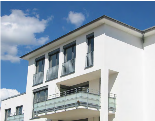
ABB. 057 ✅ Ein klarer Dachabschluss unterstützt die kubische Form der Baukörper (Augustinum, Stuttgart-Killesberg).
