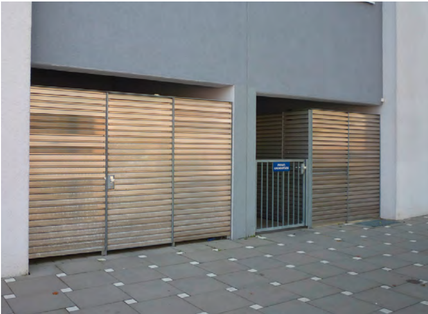
ABB. 070 ✓ Abstellflächen für Abfallbehälter und Fahrräder können auch sehr gut ins Gebäude integriert werden. Vorteil: Freiflächen werden nicht durch große Boxen verstellt.
