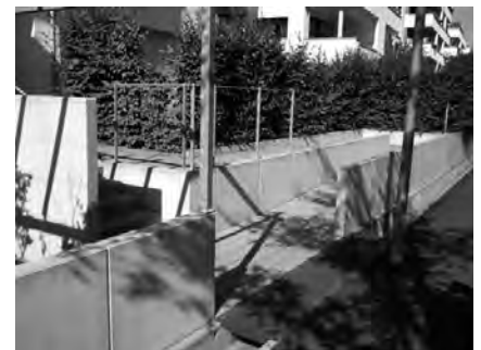
ABB. 034 ❌ NEGATIVBEISPIEL Sehr dominante Rampenanlage verbaut die Vorgartenzone.
