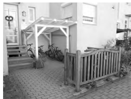
ABB. 146 × NEGATIVBEISPIEL Durch Mülltonnen sowie Fahrradabstellanlagen verbaute Vorzone. Fehlendes Grün sowie unterschiedlichste Materialien lassen den Hauszugang wenig attraktiv erscheinen.
