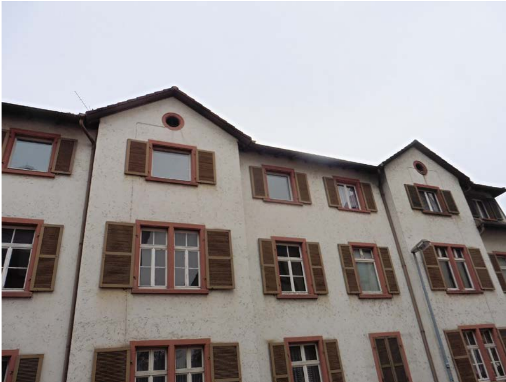
Abb. 10 Gebäude Zeller Str. 4-6 mit offenem Dachbereich
