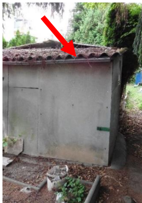
Abb. 5 - Potenzielle Spaltenquartiere von Fledermäusen am Nussbaum und einer Hütte im Vorhabenbereich (jeweils gekennzeichnet durch einen roten Pfeil)
