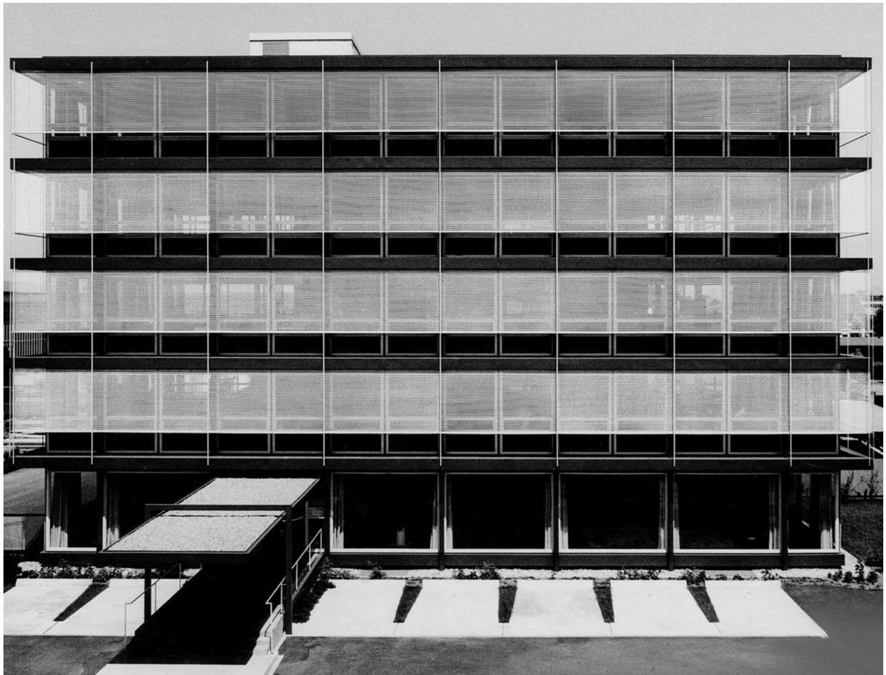
Südfassade nach Herstellung des Gebäudes ca. 1961
