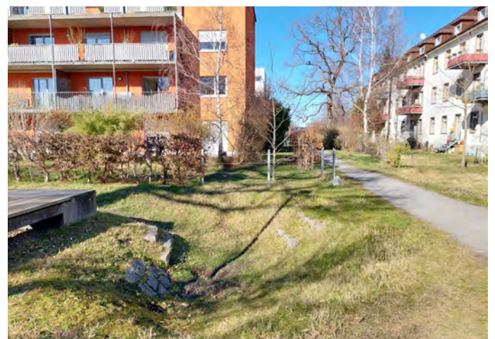
Abb. 44: Versickerungsmulde auf einer Grünfläche, Karlsruhe [1]
