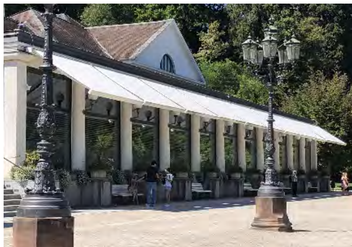
Abb. 56: Sommerlicher Wärmeschutz durch Markisen, Baden-Baden [1]
