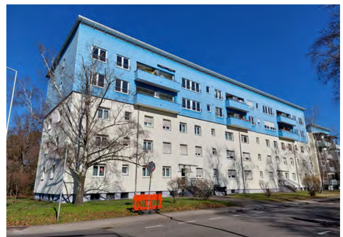
Abb. 59: Helle Fassadengestaltung bei Aufstockung, Karlsruhe [1]
